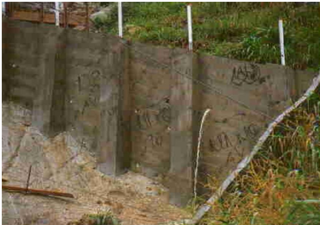
Figura 17. Drenagem de muro com barbaças
