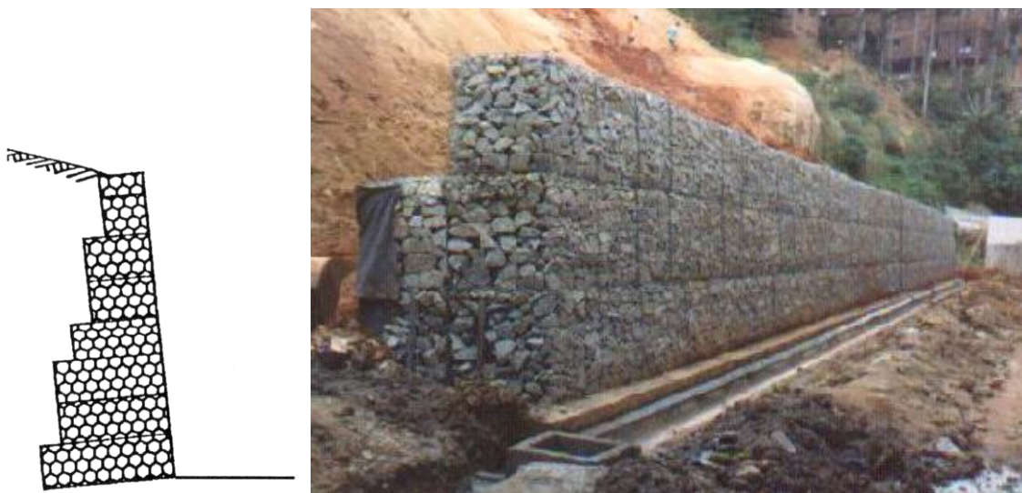
Figura 4. Muro Gabião
