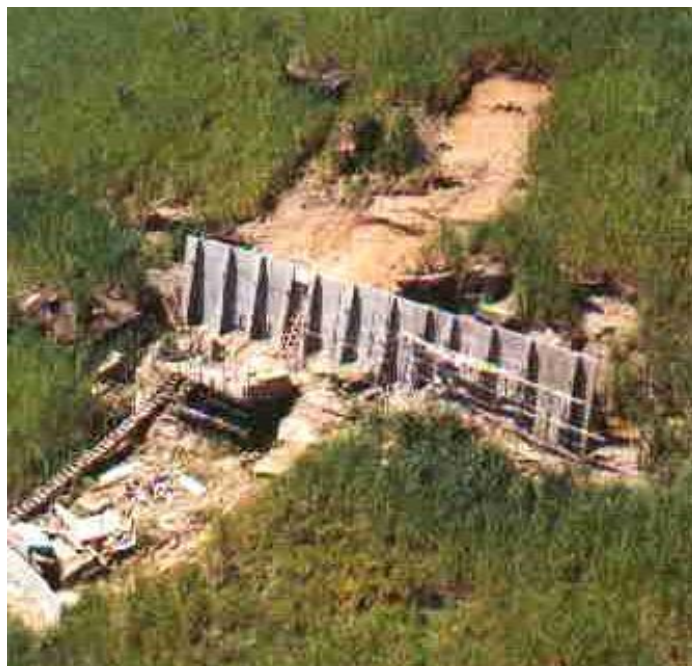
Figura 10. Muro com contraforte
