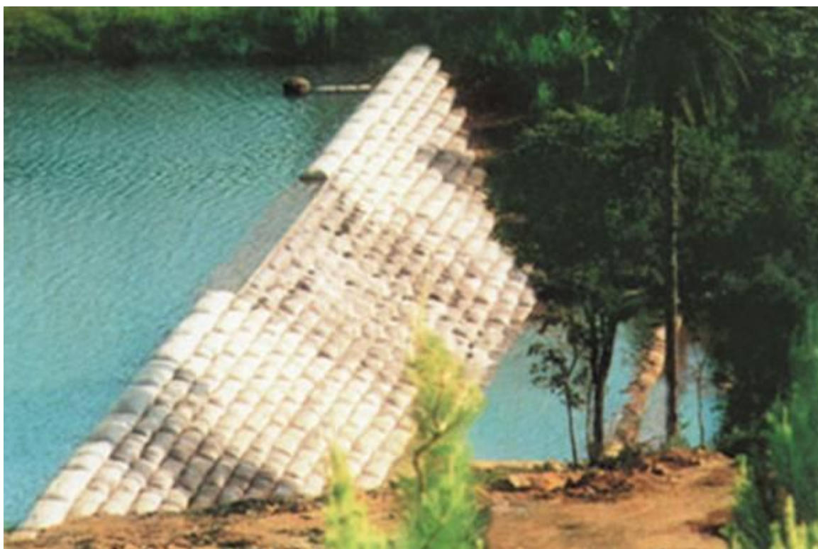
Figura 7. Ilustração de muro com sacos de solo-cimento
