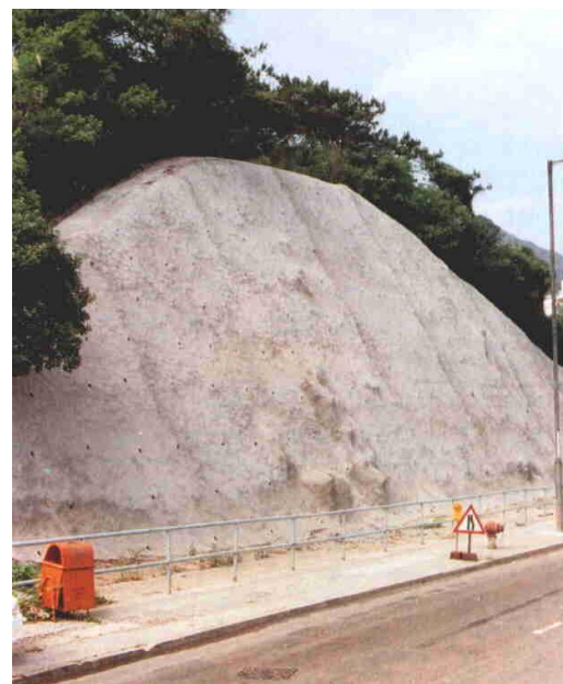
(b) impermeabilização com concreto projetado
