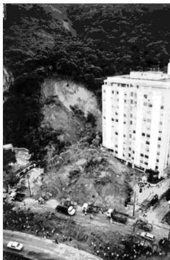
Figura 1 – Vista do escorregamento
