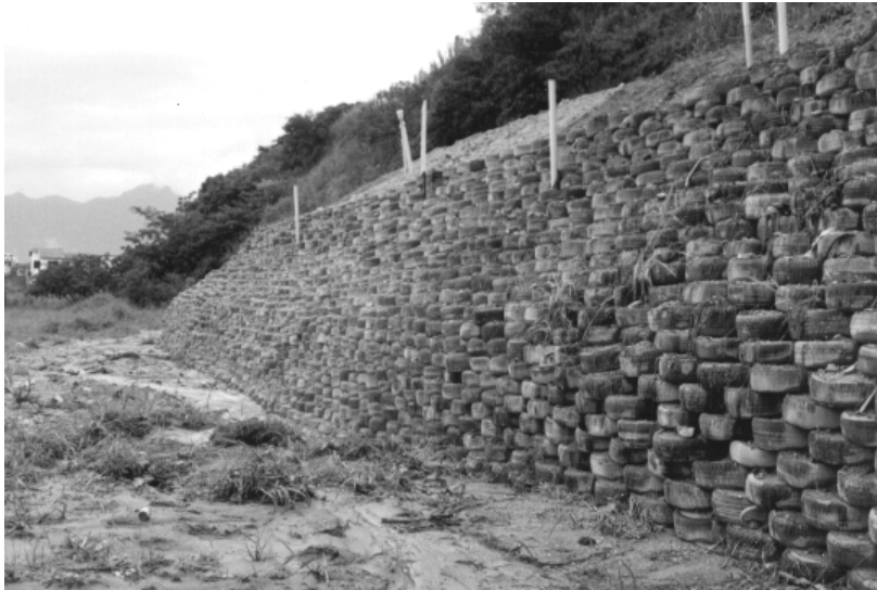
Fig. 2 - Final da construção do muro com a sobrecarga.
