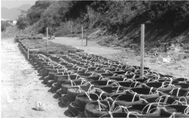
Fig. 1 - Posicionamento das camadas iniciais do muro de pneus
