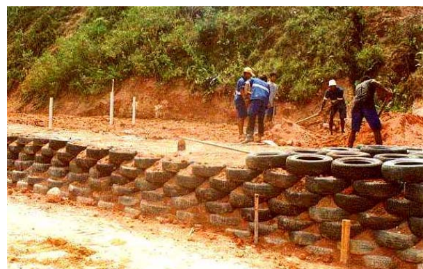
(d) Manual operations for filling tires
