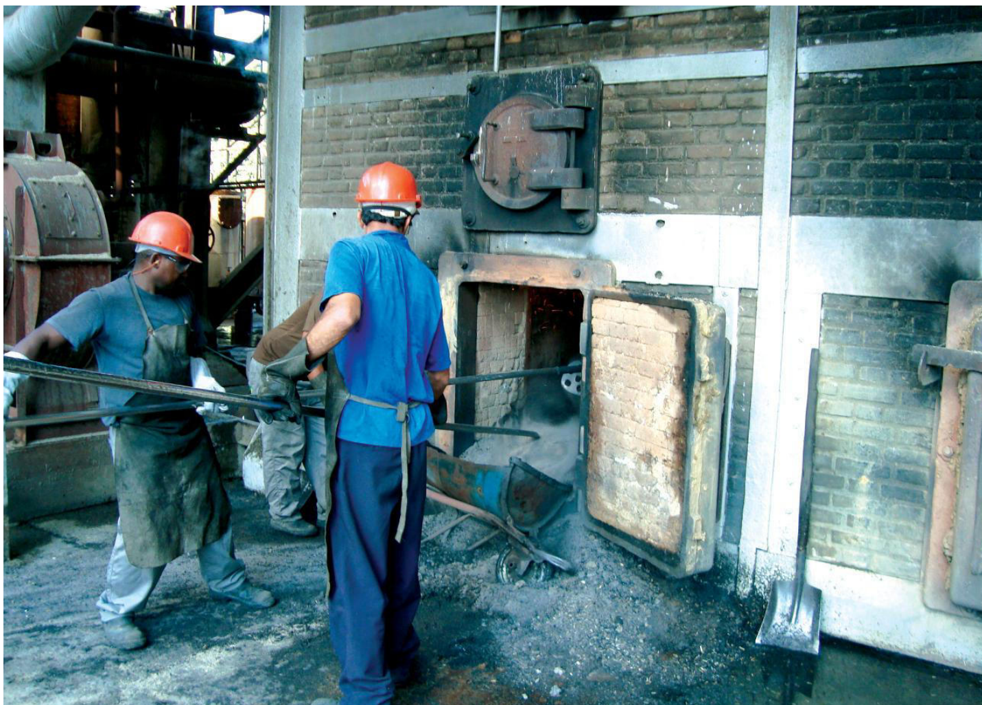
Coleta de cinzas do bagaço de cana, em usina de Campos dos Goytacazes: matéria-prima para a produção de cimento sustentável
