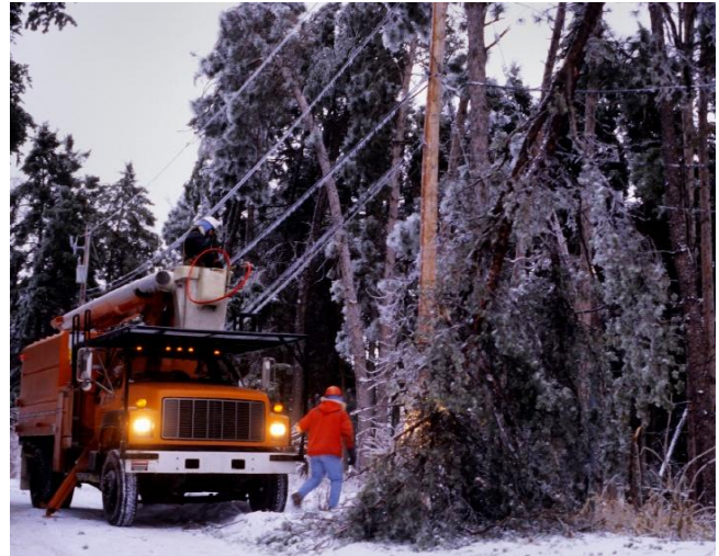
Fig. 3. Os trabalhadores de linhas elétricas enfrentam condições adversas.
