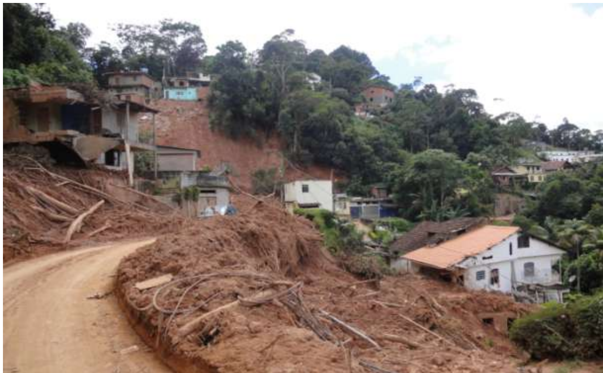
Figura 44: Bairro Granja Florestal, Teresópolis. Foto (25.01.2011). Notam-se diversos deslizamentos e destruição de casas edificadas em áreas com inclinação acima de 45^\circ (APPs).
