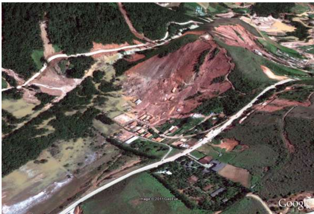
Figura 75: Imagem Google Earth 19.01.2011. Condomínio do Lago, BR 492. Nova Friburgo. Observa-se deslizamento associado à intervenção humana (construção de estradas e topo de morro desmatado). No condomínio morreram 9 pessoas.
