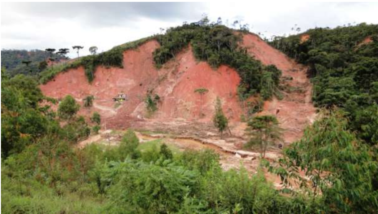
Figura 66: Foto (24.01.2011) mostrando detalhe de casa soterrada na encosta e área atingida na margem do rio. Nota-se o topo do morro desmatado.
