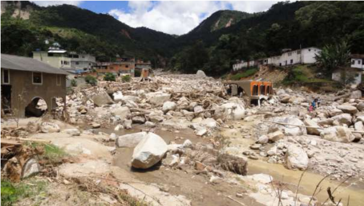
Figura 34: Vista geral da vila do Bairro Campo Grande após a tragédia. Local mostra encontro do rio principal com afluente e toda a destruição provocada pela força da água, corrimento de lama e pedras, atingindo severamente todas as construções edificadas em área de APP. Foto de 25.01.2011.
