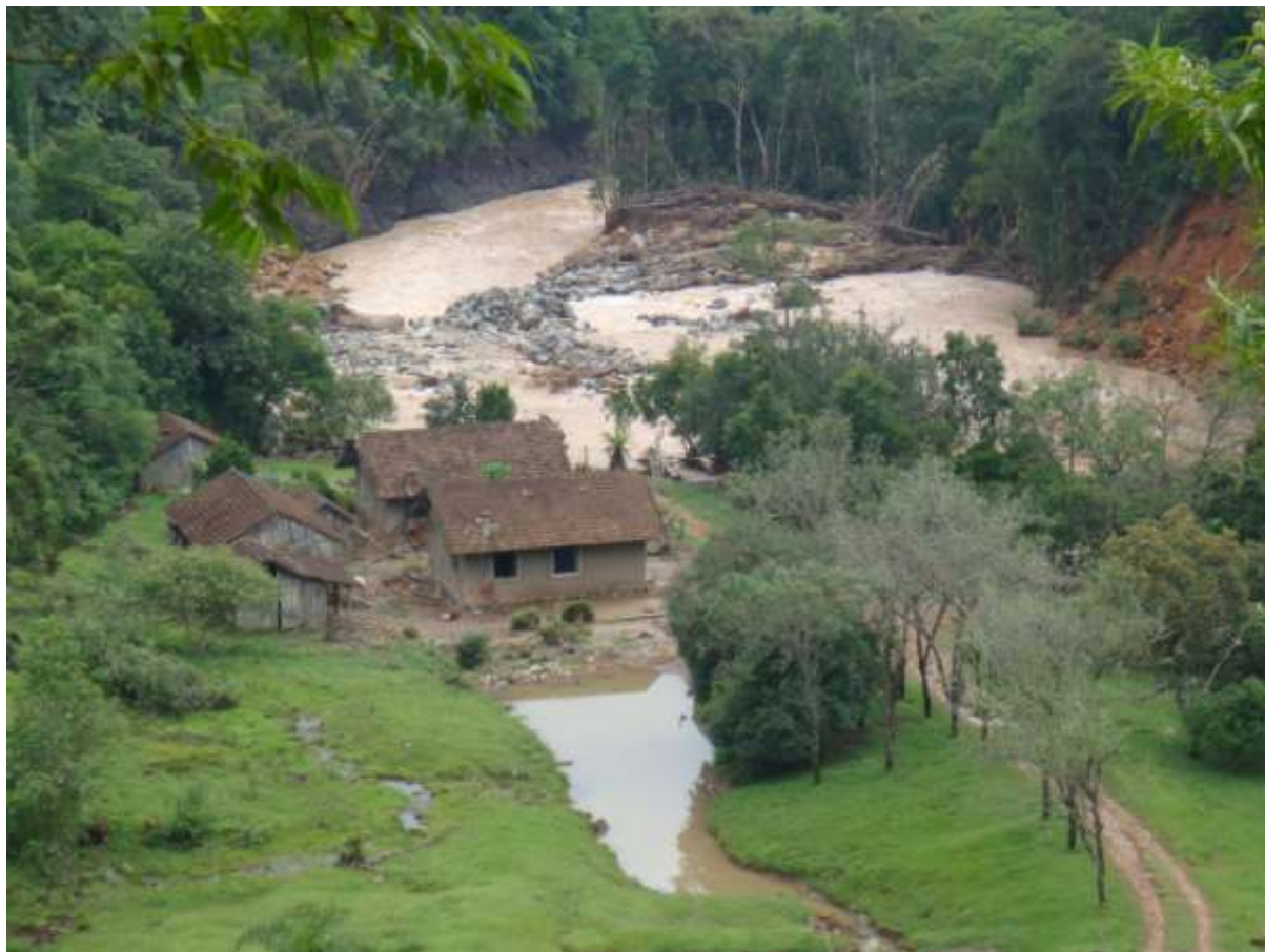
Figura 12: Casas e outras edificações construídas em APP de margem de cursos d'água, atingidas por enchente em Mirim Doce-SC Em todas as tragédias o cenário é semelhante e mostra que as áreas mais severamente atingidas são aquelas consideradas de preservação permanente pelo Código Florestal. (Foto: Lucia Sevegnani - 22.02.2011).
