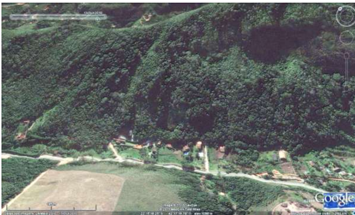
Figura 61: Vista de região com parcelamento de solo com construções na base de encosta íngreme e margem de riacho. BR 492 em Nova Friburgo. (Google Earth de 13.10.2010).
