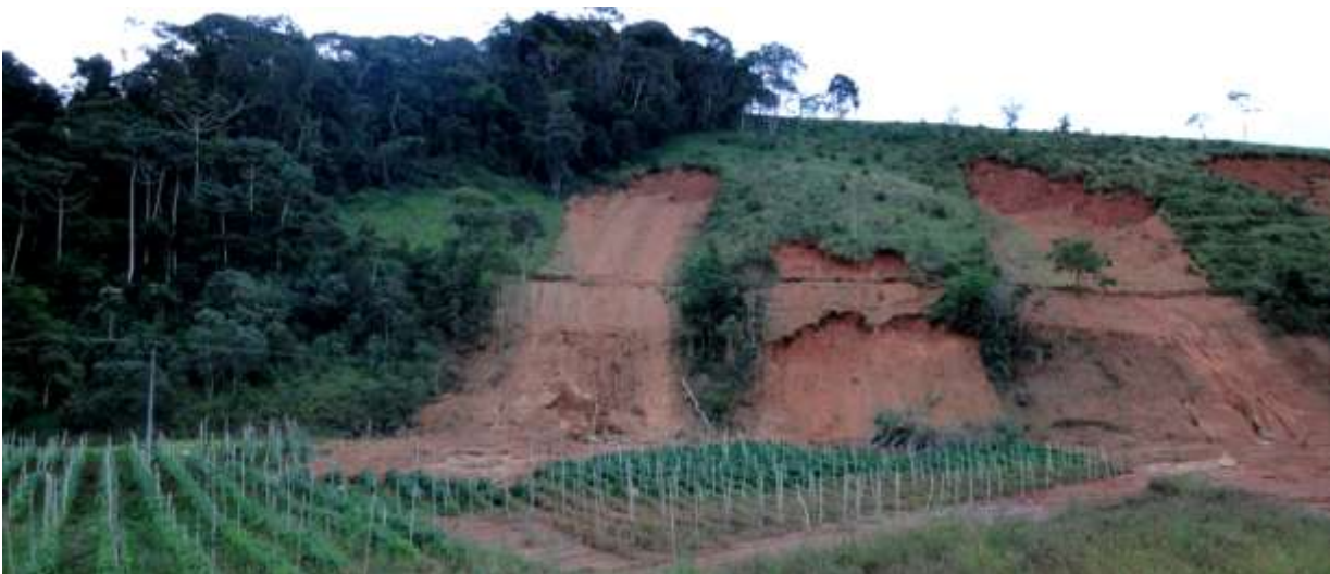
Figura 80: A Foto (24.01.2011) mostra desbarrancamento em pastagem com estrada cortando a lateral do morro, afetando plantação agrícola. Observa-se também que o desbarrancamento não afetou a área de floresta.
