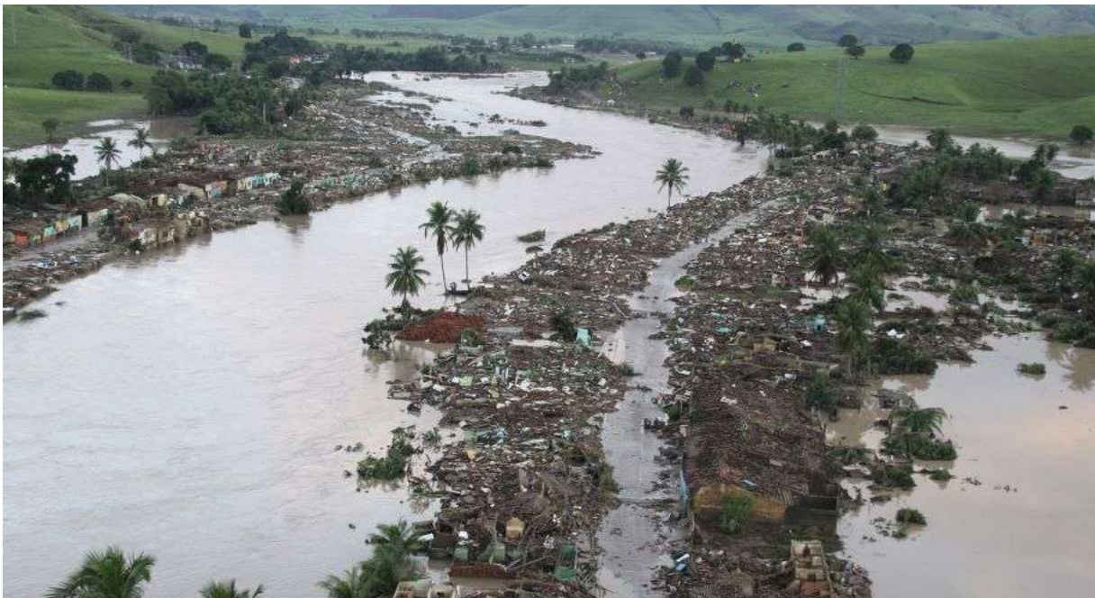
Figura 13 - União dos Palmares, a 80 km de Maceió-AL. A foto mostra que a área mais duramente afetada é a faixa de APP (50 m em cada lado do rio) Foto: Thiago Sampaio/Agência Alagoas 18 .
