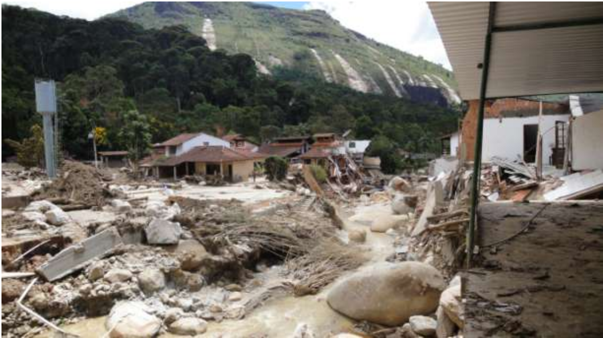
Figura 36: Vista de área afetada às margens de curso d'água no Bairro Campo Grande. Percebe-se que as edificações atingidas estavam dentro da faixa de APP, praticamente em cima do rio. Foto de 25.01.2011.
