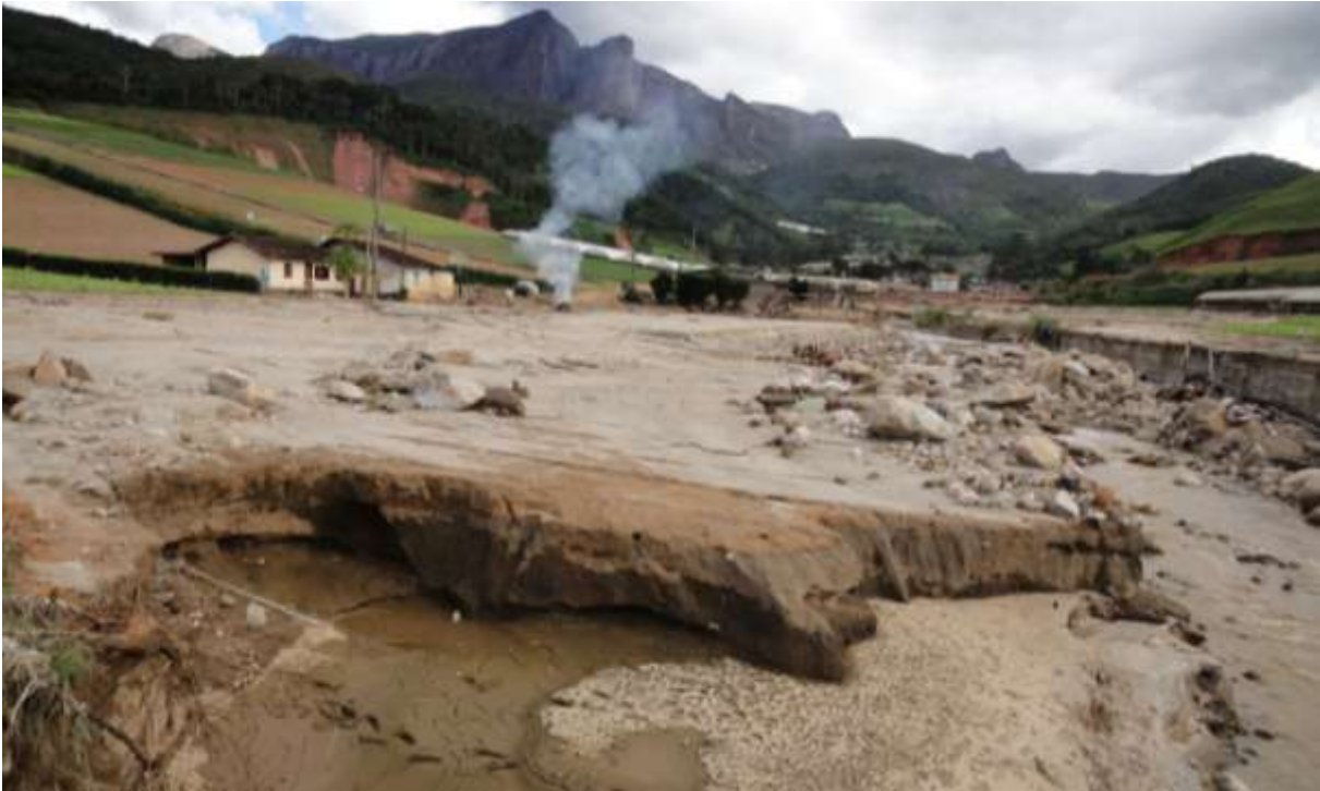
Figura 10: Distrito de Bonsucesso – Teresópolis-RJ. A foto (24.01.2011) mostra a erosão das margens e a perda do solo na área de APP ocupada por agricultura. O solo perdido contribui com o assoreamento dos rios e potencializa os efeitos das enchentes a jusante.
