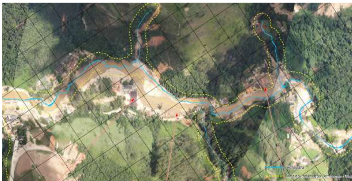
Figura 51: Foto aérea da mesma área (26.01.2011). Observa-se que a área mais severamente afetada abrange a faixa de APP de 30 metros em cada lado da margem dos cursos d'água.
