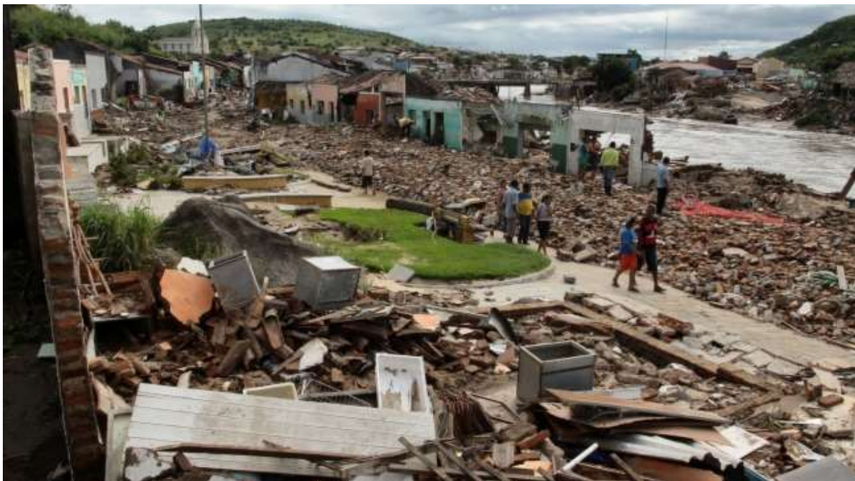
Figura 15 – Cidade de Quebrangulo-AL. A foto mostra a destruição de edificações e infra-estrutura urbana na faixa marginal do rio (APP). Foto: Futura Pres. 20 .
