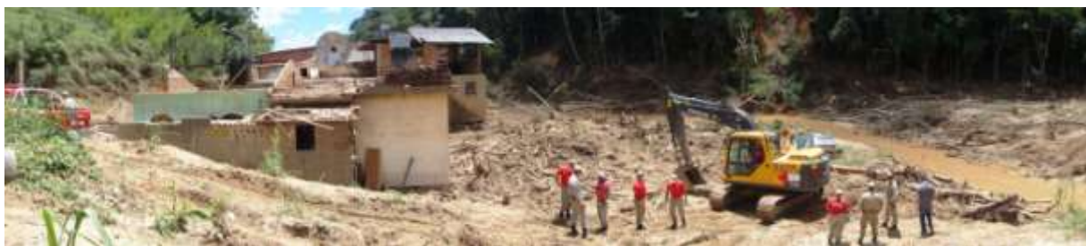
Figura 54: Vale do Cuiabá. Foto (25.01.2011) mostra casas construídas à margem do rio (na faixa de APP) severamente afetadas pela força das águas. Na margem oposta, onde não havia ocupação humana, o rio também transbordou.
