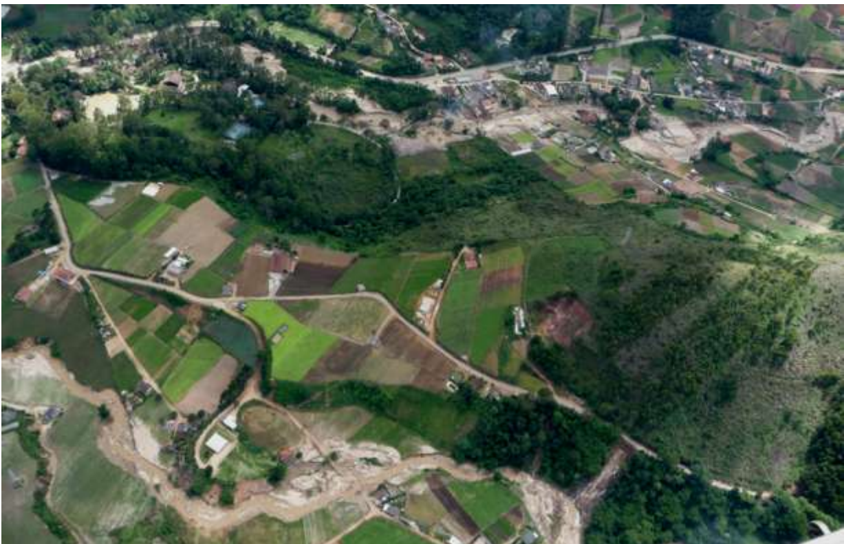
Figura 24: Vista da área rural do Alto Vieira, logo a montante da Vila de Vieira (Foto aérea de 26.01.2011), mostrando que mesmo pequenos riachos transbordam, destruindo lavouras e edificações, principalmente dentro da faixa de APP ocupada indevidamente.
