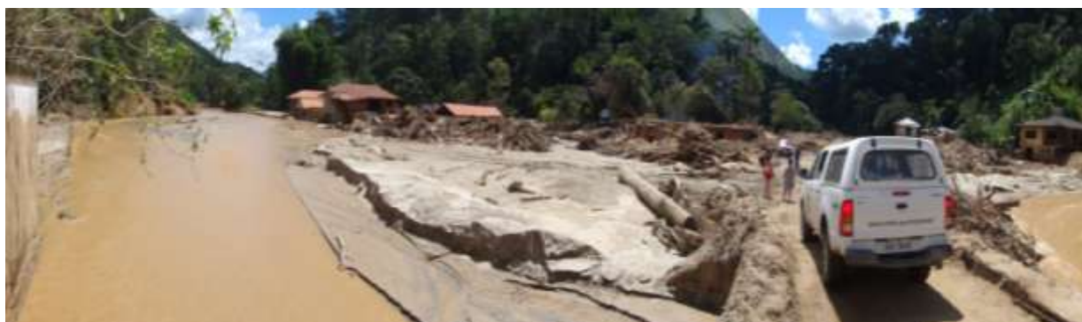
Figura 52: Foto da área do encontro dos rios (25.01.2011). Observa-se a destruição das casas localizadas próximo às margens dos cursos d'água.
