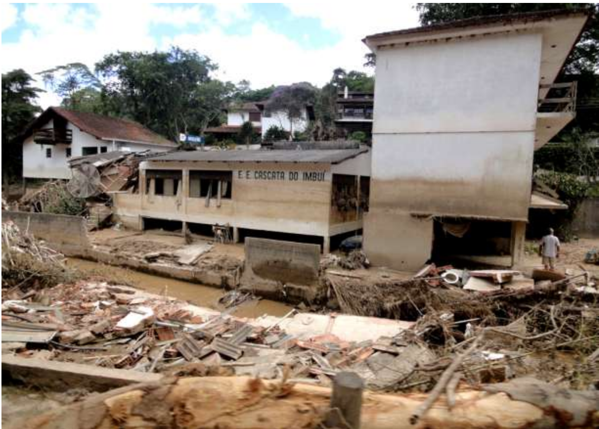
Figura 37: Vista da Escola Estadual Cascata do Imbuí – Teresópolis, após a tragédia. A foto mostra a escola, casas e prédios, edificados em APP, severamente atingidos pela subida das águas. Observa-se também que a canalização do rio não conteve a força das águas. Foto de 25.01.2011.
