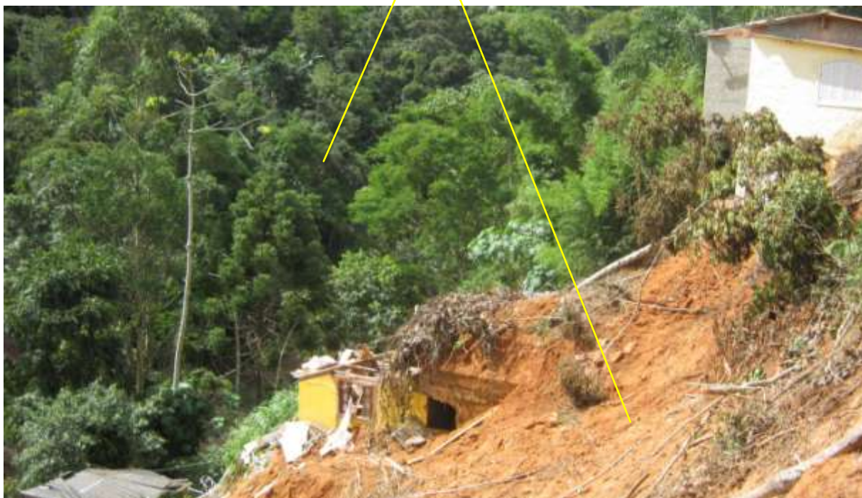
Figura 39: Detalhe de casas atingidas por desmoronamento, localizadas em APP de margem de rio e inclinação superior a 45°. Na margem oposta do rio, a vegetação permaneceu intacta (Foto: 25.01.11).
