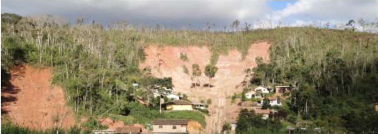
Figura 78: Foto (24.01.2011) do mesmo Loteamento ( Figuras 76 e 77 ). Observa-se a alta declividade e a vegetação remanescente, recentemente atingida por queimada. As queimadas em encostas e topos de morro destroem a vegetação nativa e contribuem na desestabilização do solo.
