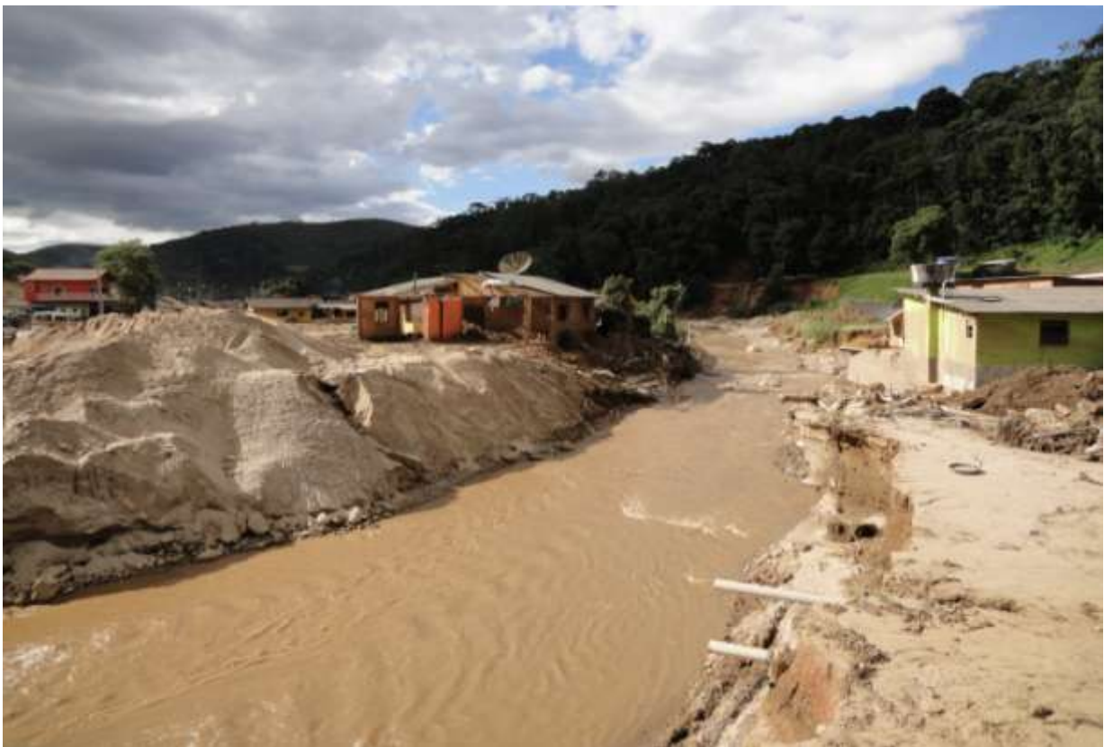
Figura 26: Vista do rio obtida da ponte a montante da Vila de Vieira. Área afetada pela corrida de lama e inundação com destruição de residências localizadas na margem do rio. Foto de 24.01.2011.
