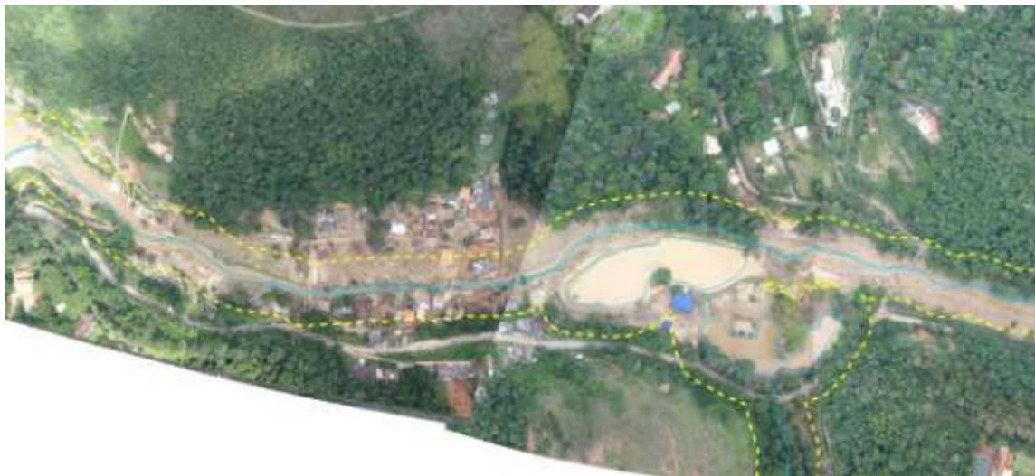
Figura 5. Fotografia aérea de 26 de janeiro 2010 com hidrografia interpretada em azul e APP de 30m delimitada em amarelo tracejado.
