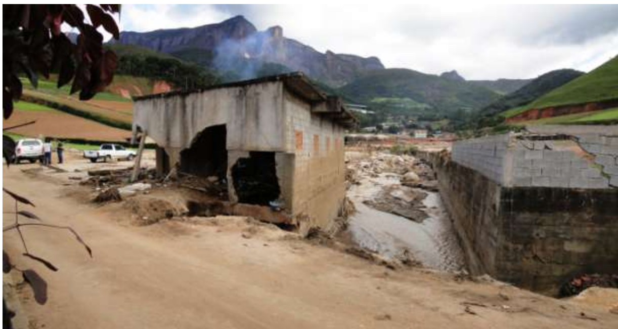
Figura 19: Localidade de Bonsucesso – Teresópolis-RJ. Na foto aparece em detalhe o tamanho do rio, mostrando sua pequena largura (menos de 5 metros). Além de edificações, logo a montante da ponte, literalmente em cima de ambas as margens. Observa também que o rio era parcialmente canalizado a montante. Foto de 24.01.2011.
