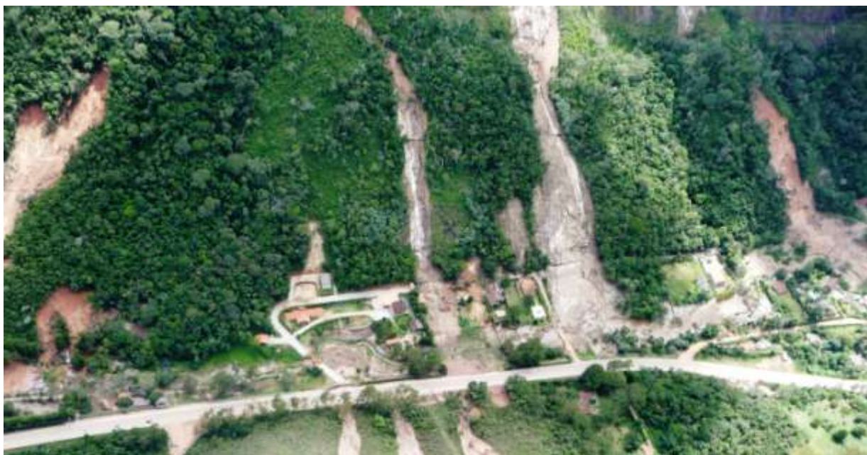
Figura 62: Foto aérea obtida em 26.02.2011, da mesma região às margens da BR 492, mostrando deslizamentos na encosta que atingiram diversas casas localizadas às margens do riacho e no sopé de morro com inclinação superior a 45°. Nota-se também que entre as casas e a encosta há uma estrada pavimentada, a qual não aparece na imagem de 2006( Figura 61 ), mostrando que houve intervenção na base do morro.
