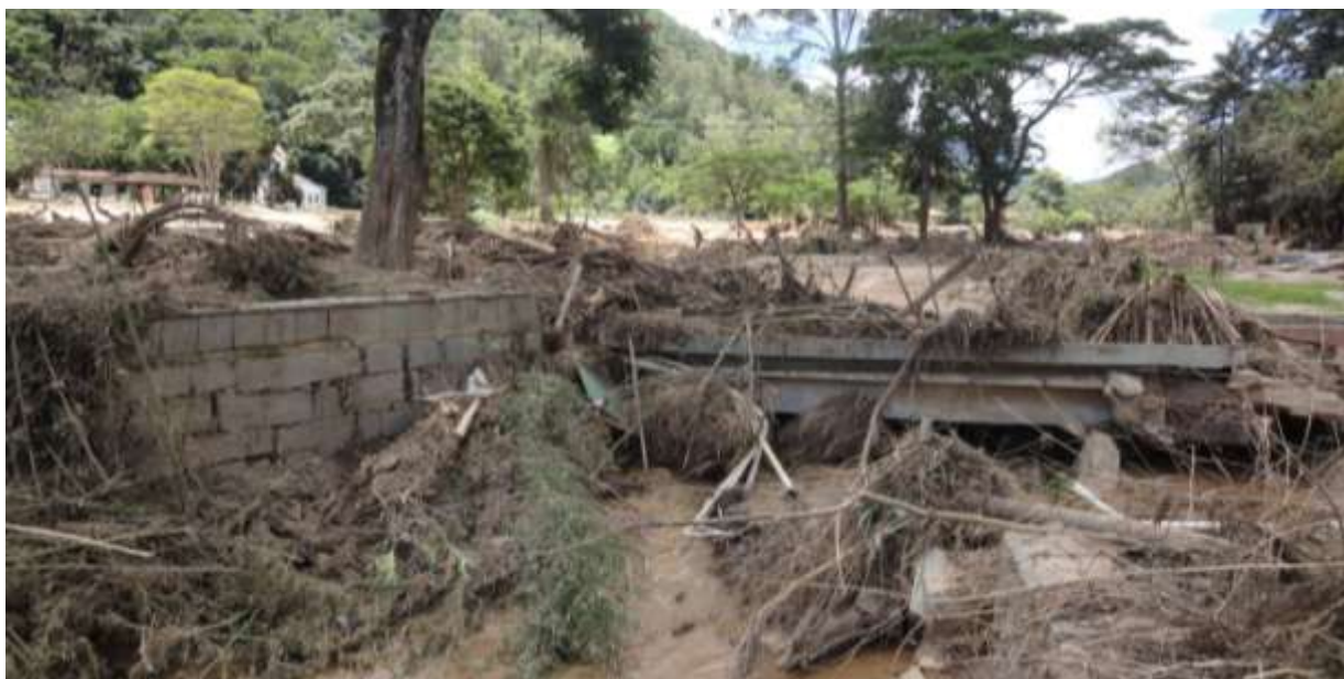
Figura 20: Pequenas pontes com vão reduzido que se tornam represas, intensificando localmente os efeitos e extensão das inundações. Vale do Cuiabá – Petrópolis. Foto de 25.01.2011.
