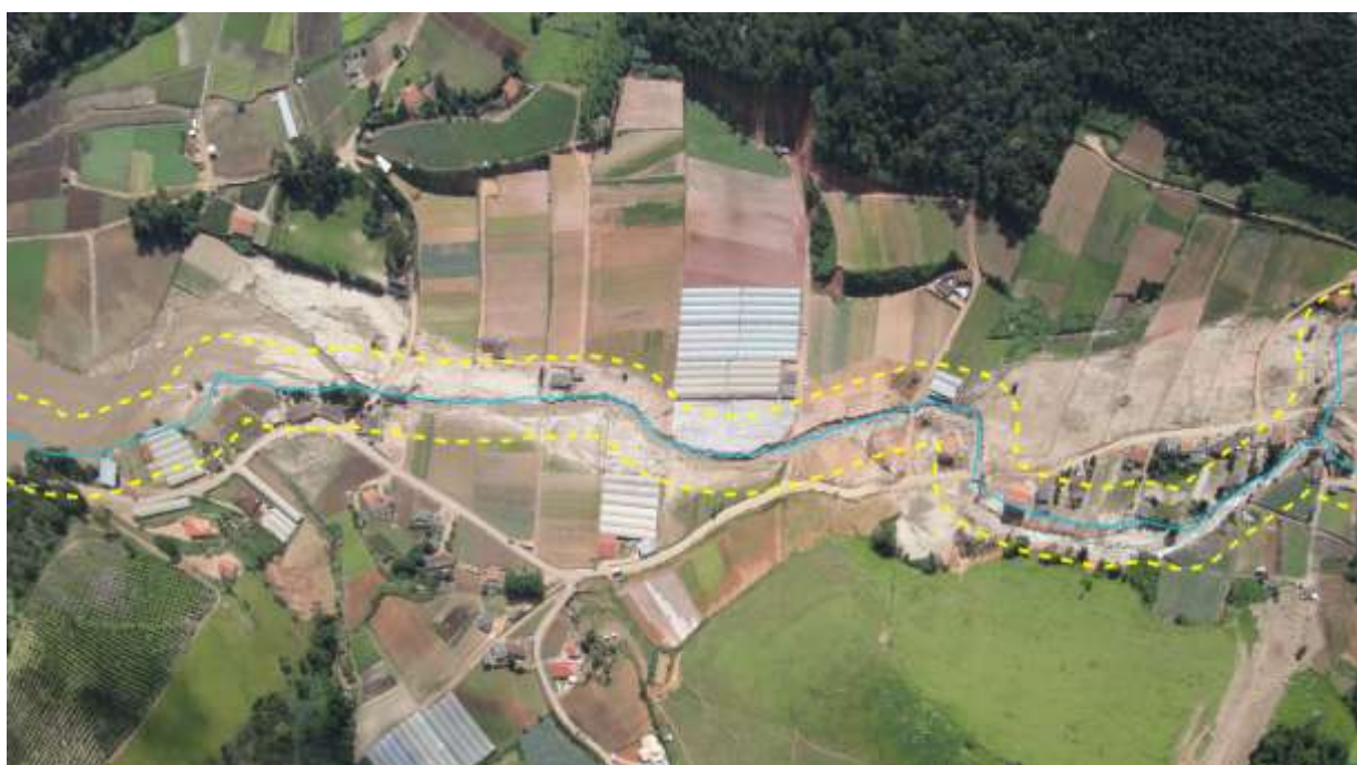
Figura 17: Localidade de Bonsucesso – Teresópolis-RJ. A foto mostra que as áreas mais severamente atingidas são aquelas situadas às margens dos cursos d’água, com grandes danos às construções, perda das lavouras e intensa erosão do solo.
