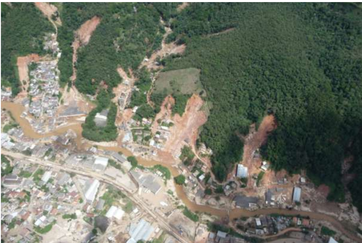
Figura 67: Foto aérea (26.01.2011) mostrando trecho do Córrego Dantas às margens da BR 492 em Nova Friburgo. Observa-se que as edificações nas margens dos cursos d'água (principal e afluentes) foram severamente afetadas. Observam-se também as construções de estradas e edificações no sopé do morro e na meia encosta, em área com declividade acima de 45°. É possível verificar ainda que na área coberta por floresta bem conservada (lado direito no alto), onde não há intervenção humana próxima, não ocorreram deslizamentos.
