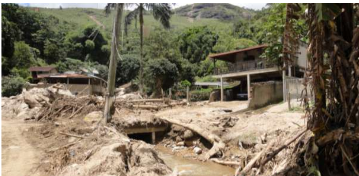
Figura 32: Pequenas pontes com vão reduzido que se tornam represas, intensificando localmente os efeitos e extensão das inundações. Vila do Bairro Campo Grande - Teresópolis. Foto de 25.01.2011.
