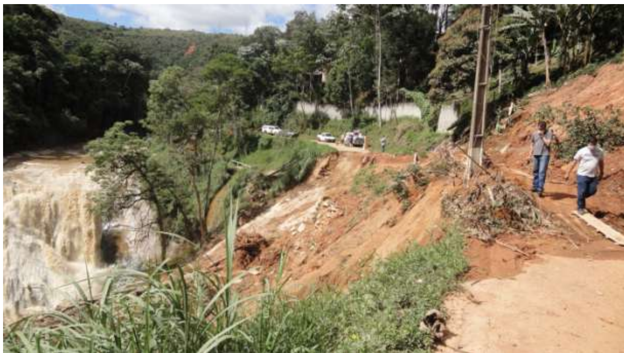
Figura 40: Vista da Cascata do Imbui em, Teresópolis, com desbarrancamentos que atingiram casas na margem direita da estrada, localizadas em declividade acima de 45° Foto: 25.02.2011.
