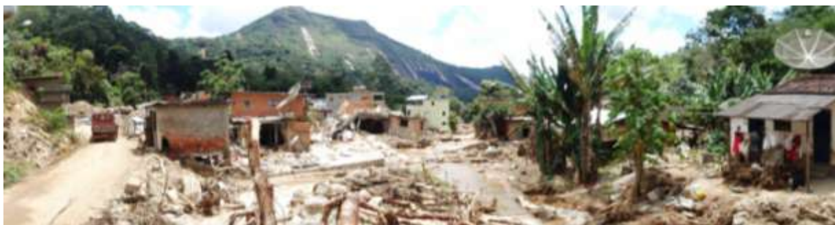
Figura 33: Vista geral da destruição provocada pela força da água às margens do afluente do rio na vila do Bairro Campo Grande em Teresópolis. Foto de 25.01.2011.
