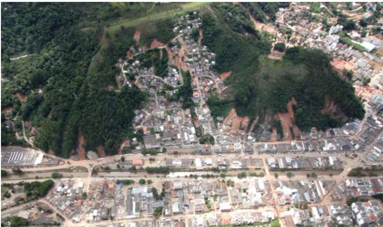
Figura 84: Nova Friburgo. Foto aérea (26.01.2011) da mesma área. Podem-se observar deslizamentos na encosta ocupada, e a lateral do rio (canalizado) totalmente ocupada por edificações, as quais foram afetadas pela inundação.
