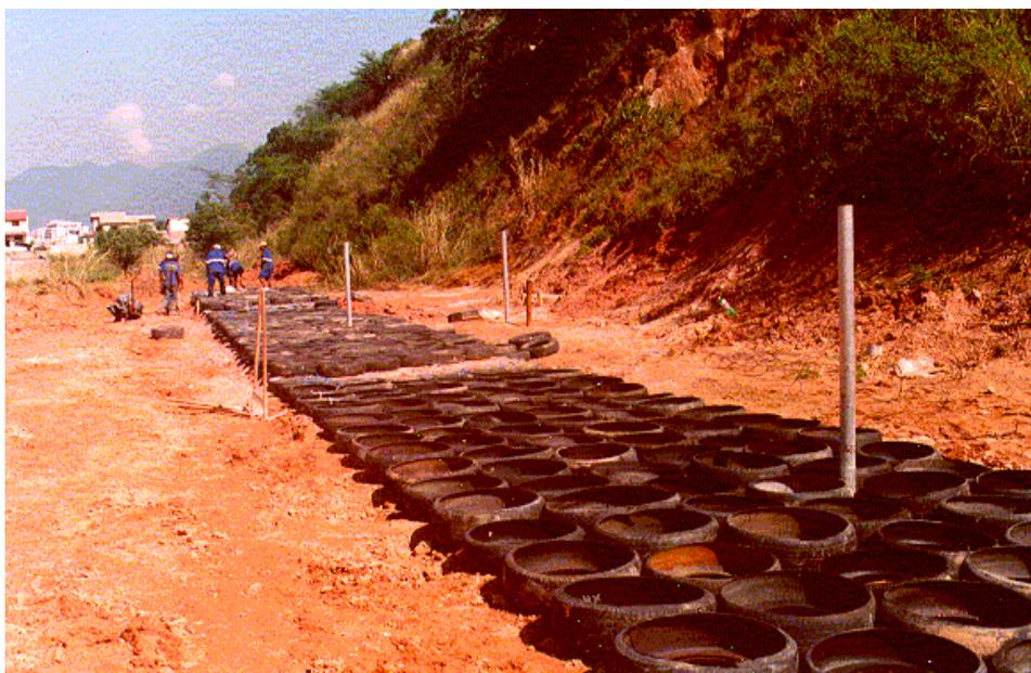
Figura 1 – Inicio de la construcción del muro.
