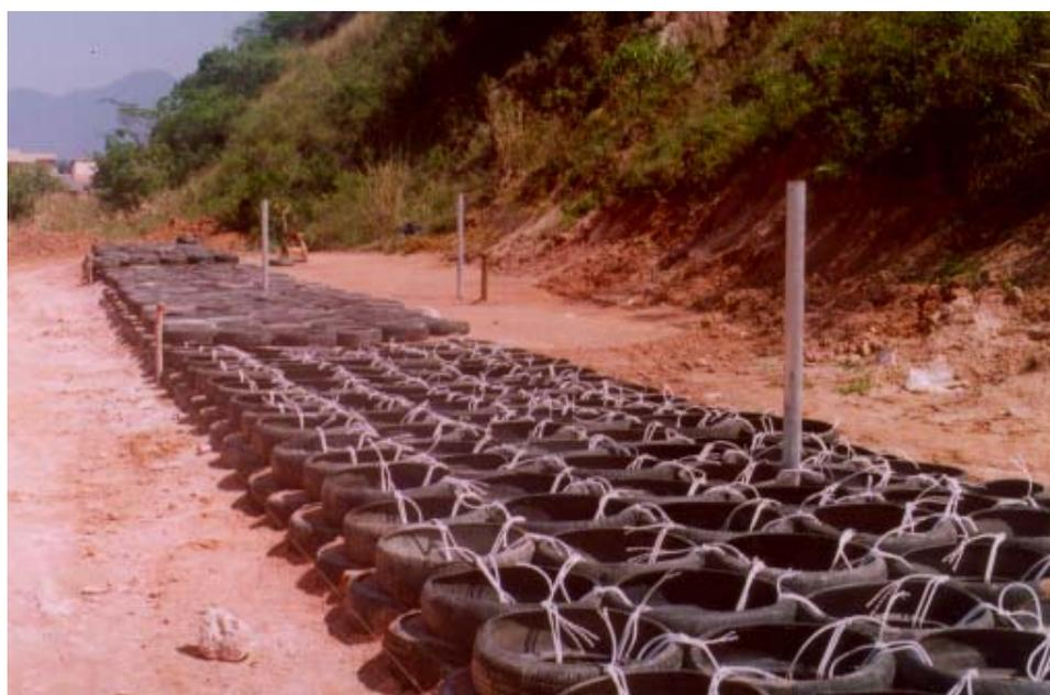
Figura 2 – Atado de los neumáticos del muro.
