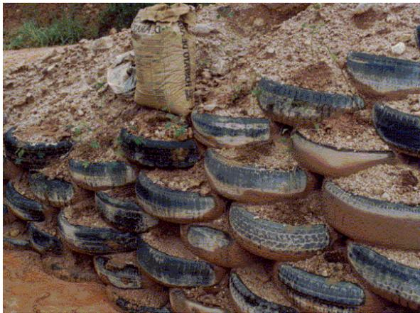
(c) Detalhe da face do muro
