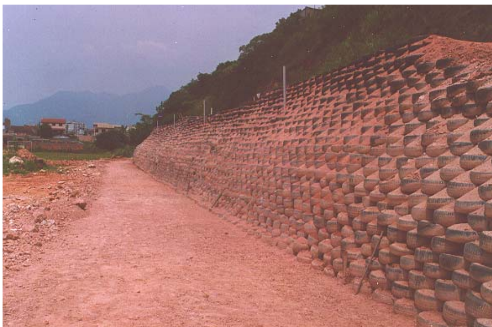
Figura 2 – Final da Construção do Muro.
